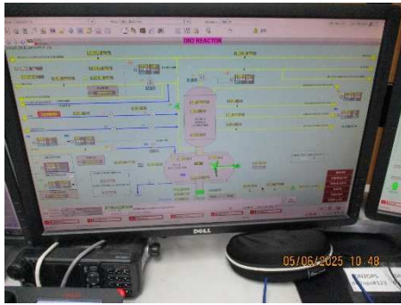
ภาพที่ 2.2-34 ระบบหยุดการป้อนโมโนเมอร์ ระบบ Redundancy Measurement และระบบสั่งปิดวาล์วอัตโนมัติ
