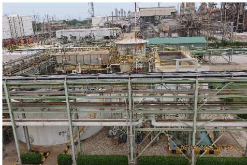
ภาพที่ 2.2-8 ระบบบำบัดน้ำเสีย ระบบ Extended Activated Sludge System
