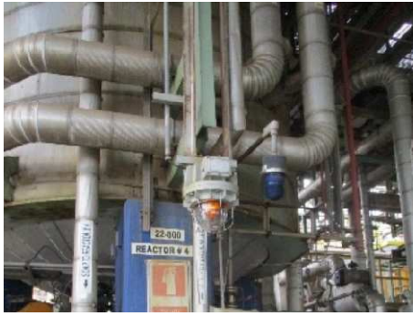
ภาพที่ 2.2-6 อุปกรณ์ตรวจจับก๊าซและเตือน (Detection & Alarm)
