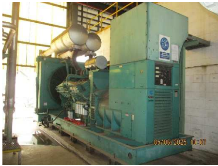
ภาพที่ 2.2-1 เครื่องสำรองไฟฟ้าเพื่อจ่ายไฟให้กับ RTO Generator Supply
