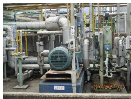
ภาพที่ 2.2-5 ระบบ Double Seal Liquid Buffer
