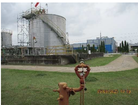
ภาพที่ 2.2-40 ระบบดับเพลิงบริเวณถังเก็บสไตรีน และบริเวณถังเก็บอะคริโลไนไตรล์
