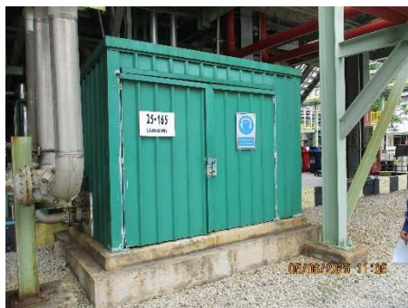
ภาพที่ 2.2-18 Noise Absorber บริเวณ Blower
