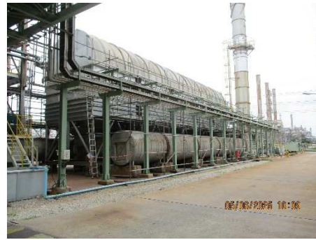
ภาพที่ 2.2-2 Regenerative Thermal Oxidizer (RTO)
