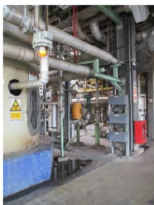
ภาพที่ 2.2-33 อุปกรณ์ตรวจจับและเตือน (Detection & Alarm)
