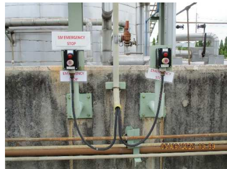
ภาพที่ 2.2-39 ระบบความปลอดภัย บริเวณถังเก็บสไตรีน และถังเก็บอะคริโลไนไตรล์
