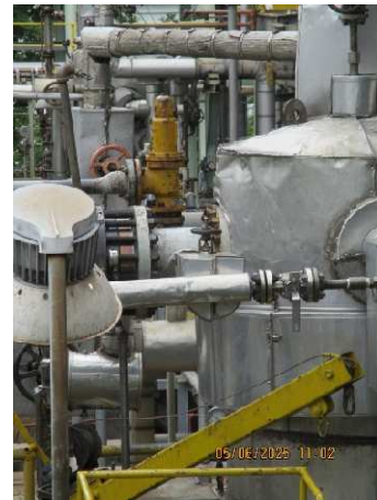
ภาพที่ 2.2-35 Rupture Disc & Blowdown Tanks
