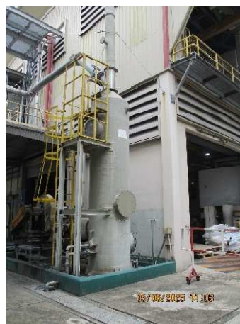
ภาพที่ 2.2-4 Wet Scrubber ของเครื่อง Small Lot Extruder
